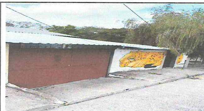
Foto 5: MÓDULO 4. Remozamiento completo de portón, lijado, pintado y sustitución de pasador por chapa.
