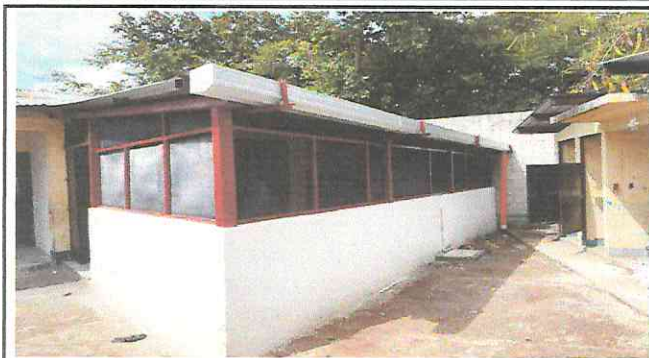
Foto 1: MÓDULO 1. Remozamiento completo de muro de cocina de mampostería y malla compuesta por cimiento corrido con 5 hiladad de block.
