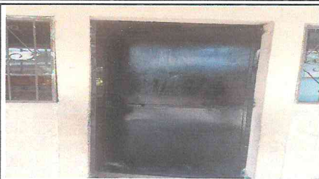
Foto 2: MÓDULO 2. Remozamiento completo de puertas en aulas y cambio de chapas.
