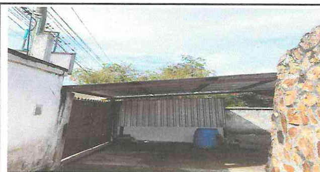
MÓDULO 4. Sustitución completo de lona por lámina.
