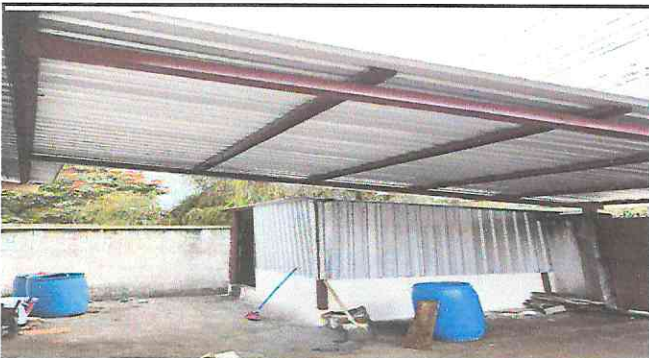
Foto 3: MÓDULO 3. Remozamiento completo de paredes y techo con hiladad de block.
